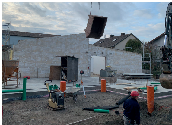
Blick auf die Baustelle (Foto: Tanja Kretzschmann)
